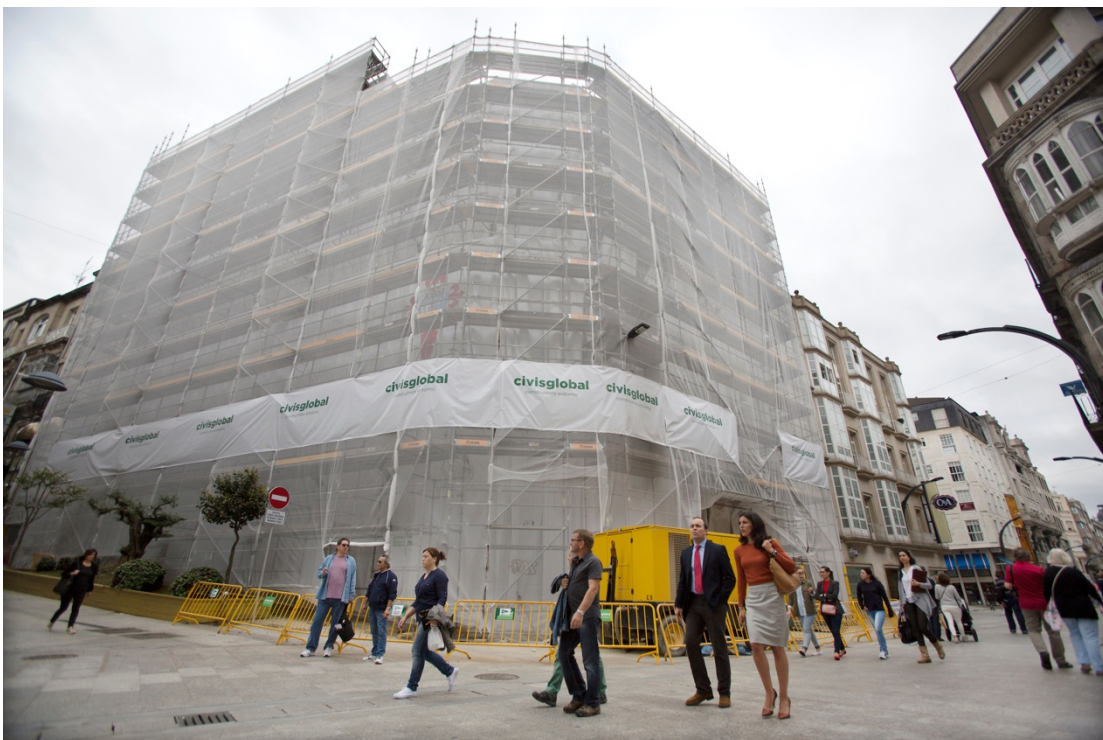
Obras de rehabilitación e construción da nova sede social do Celta, na rúa do Príncipe (Vigo).
