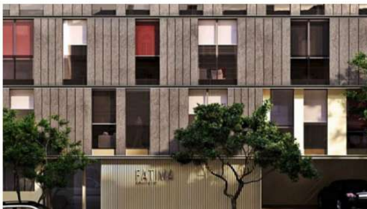
El edificio Fátima del Grupo Viqueira.
